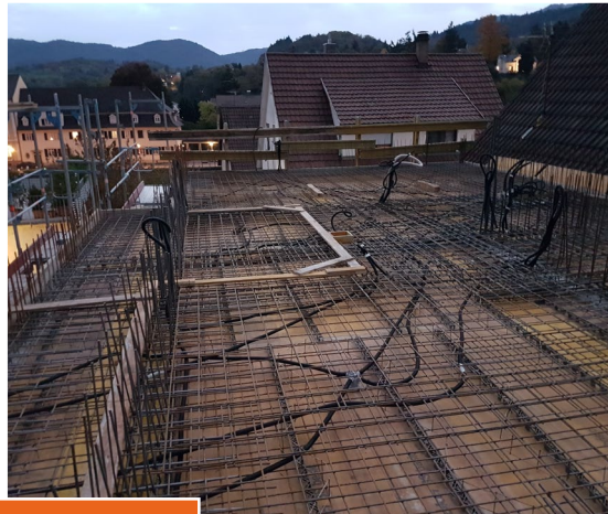
Decke über OG zweites MFH
