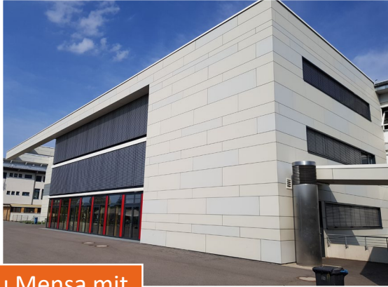
Neubau Mensa mit Sanitärtrakt
