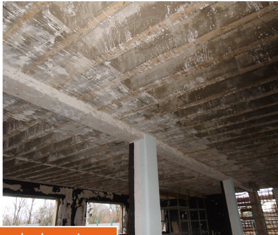
Rippendecke mit Mittenunterstützung
